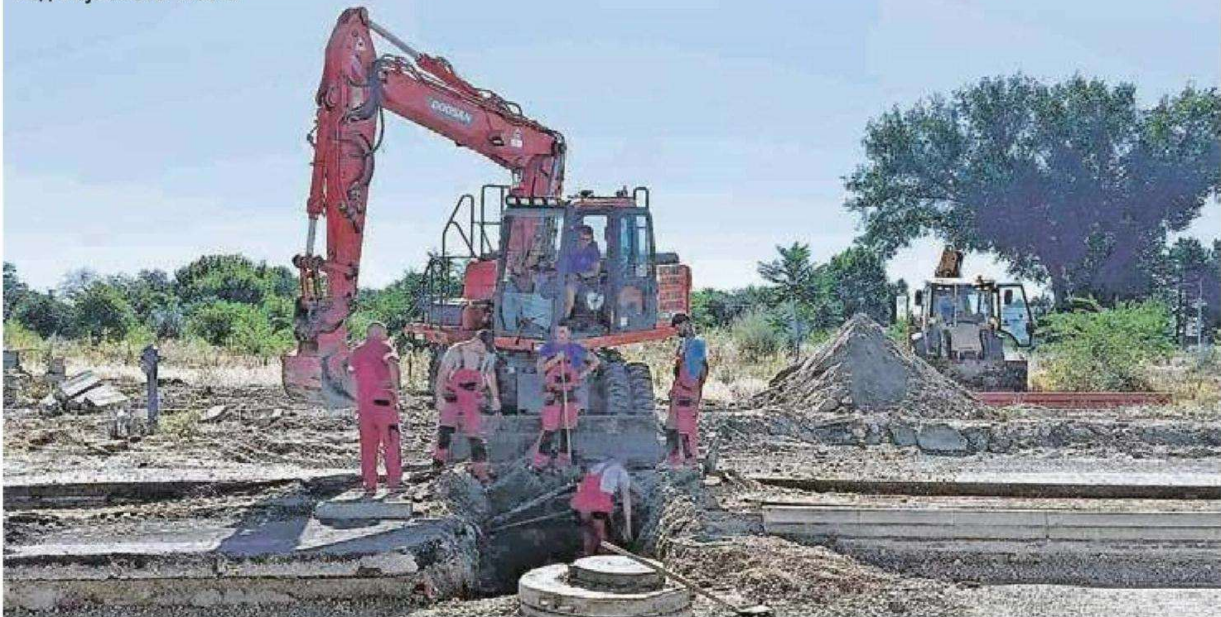
Радови на кружном току код Мајшанског моста
