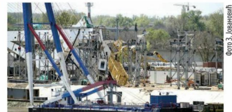
▲ ГУБИТАК Радови на новом мосту
