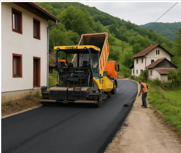
Radovi na asfaltiranju Ulice 8. marta počeli u Goduši, Priboj
