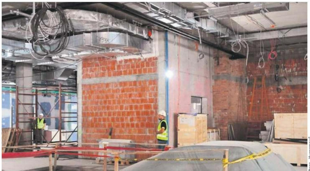
Радови на изградњи Универзитетске деце клинике „Тиршова 2“
