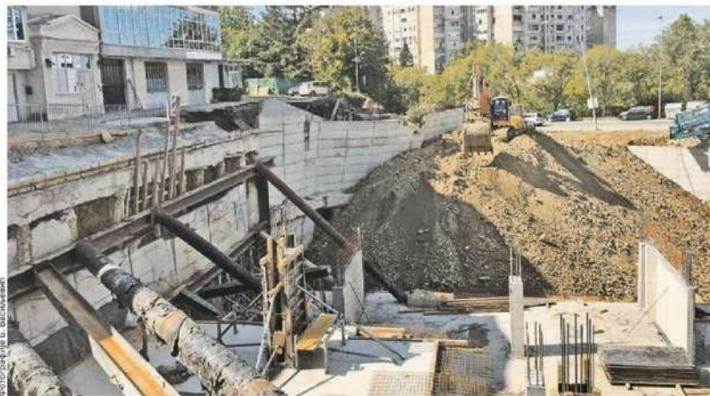
Санација темељне јаме
