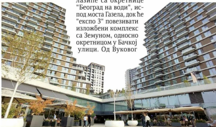
▲ ЛОКАЦИЈА Део насеља Београд на води
