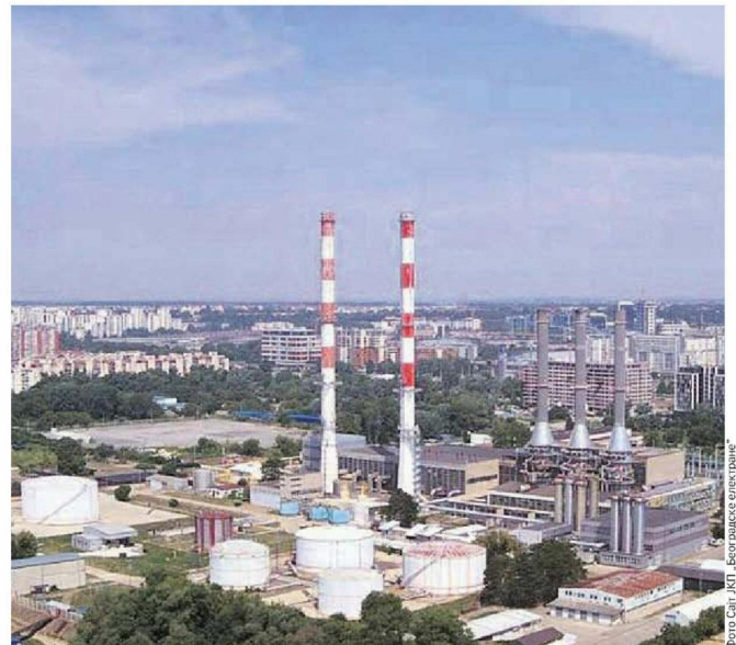
Најобимнији радови изводе се у топлани „Нови Београд“, која снабдева највећи број корисника
